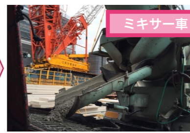
アドミックス配合 生コンクリートの打設
