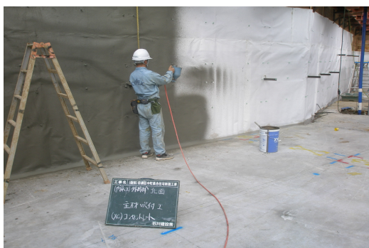
不織布貼付け及び主材吹付け
