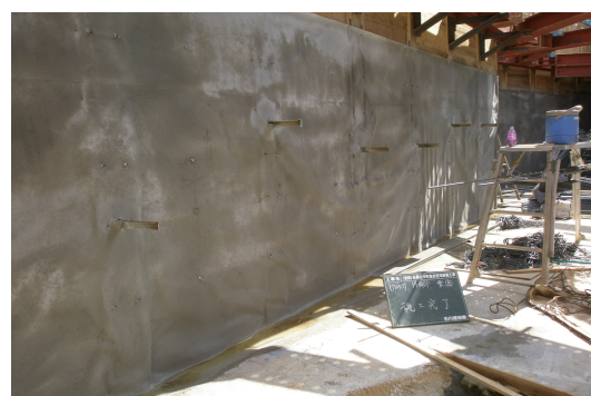
主材吹付け完了
